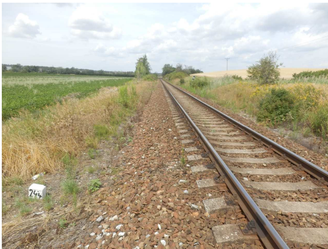
Obrázek 6: Traťový úsek Nymburk hl.n. – Mladá Boleslav hl.n., cca km 24,4, pohled ve směru staničení, dvě nové koleje navrženy vlevo od stávající koleje, včetně nového ostrovního nástupiště.
