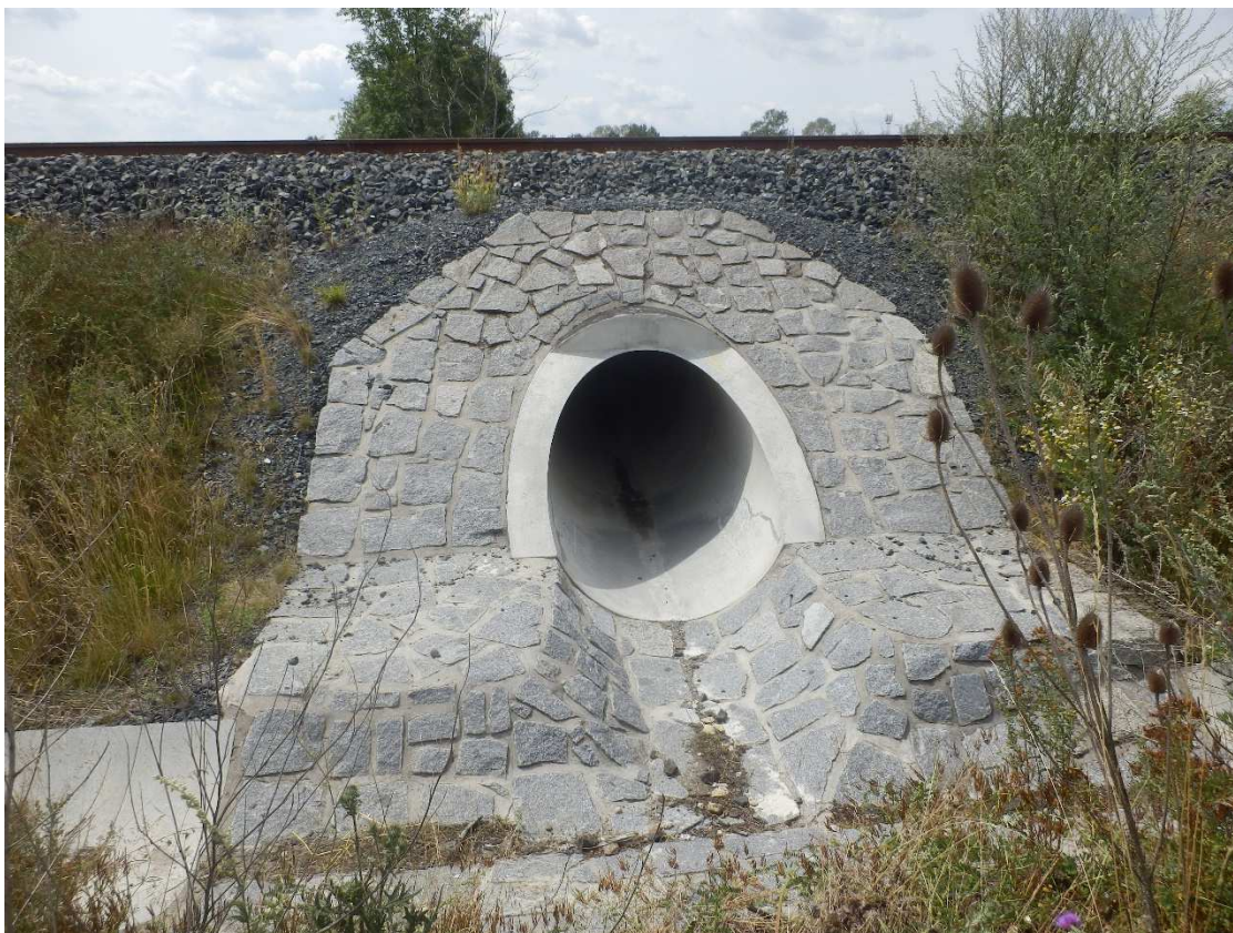
Obrázek 10: Traťový úsek Nymburk hl.n. – Mladá Boleslav hl.n., propustek v ev km 25,145, pohled na výtok, na nové dvukolejné trati bude zřízen před tímto propustkem v km 25,162 propustek nový.
