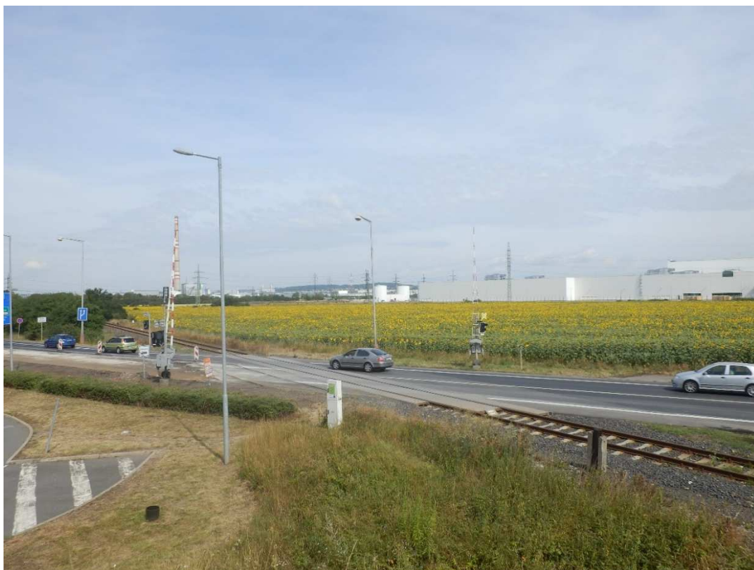
Obrázek 17: Traťový úsek Stará Paka – Mladá Boleslav město, pohled z jihu, úrovnňový přejezd P4638 v ev km 19,980 (cca km 30,46). Nová dvoukolejná trať je vedena za stávající tratí, přejezd bude zrušen a nahrazen novým silničním nadjezdem v ose stávající silnice I/16, za nadjezdem bude kolejiště ŽST. Mladá Boleslav východ.
