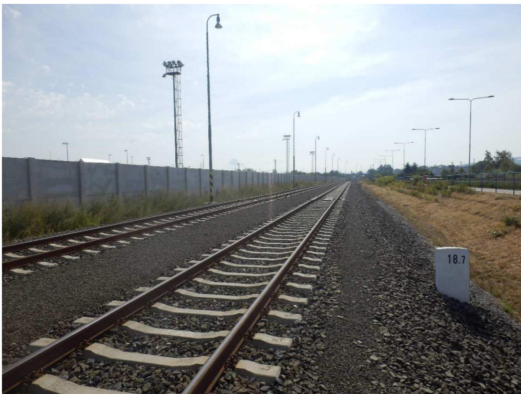
Obrázek 19: Traťový úsek Stará Paka – Mladá Boleslav město, km 18,7 pohled ve směru staničení, v ose stávajících kolejí jsou vedeny nové koleje č. 102 a 104, vpravo bude doplněna kolej č. 101, vlevo pak tři nové koleje (106, 108 a 14). Oplocení areálu Škoda auto bude demontováno a opětovně postaveno v nové poloze.
