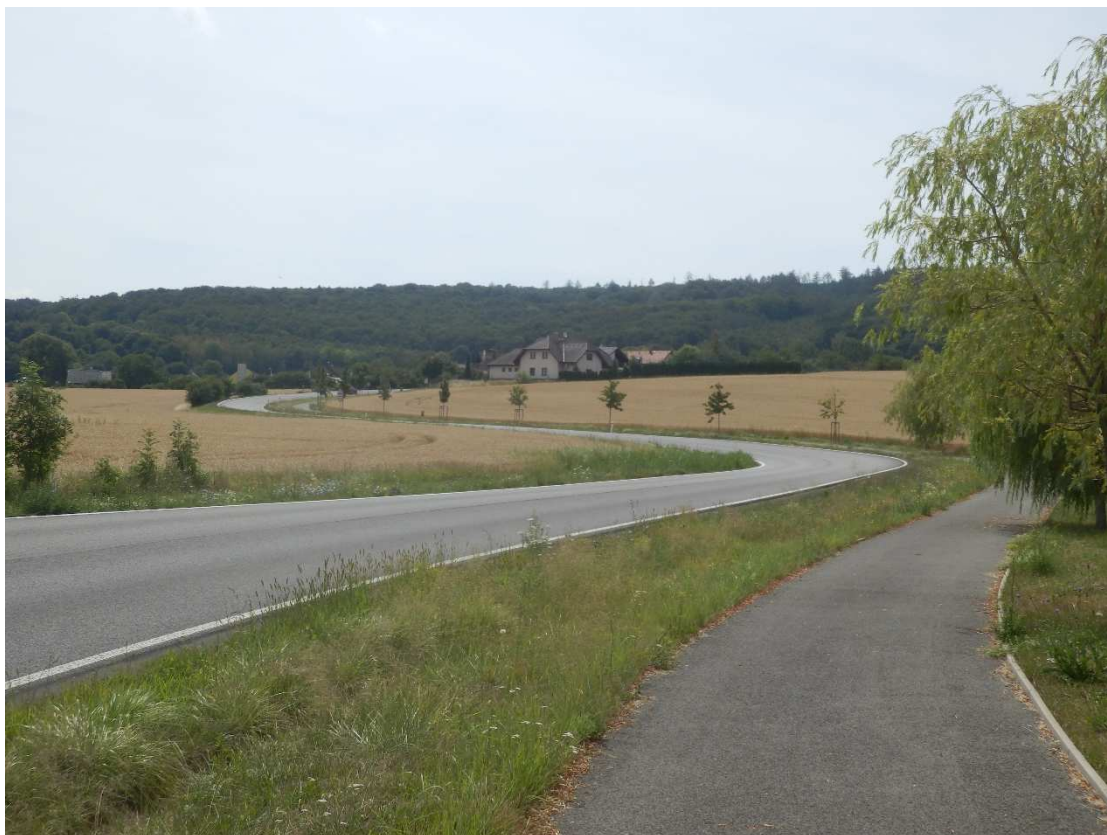
Obrázek 12: Přeložka, silnice III. Třídy č.27513 s cyklostezkou, cca uprostřed „esíčka“ komunikace vlevo je navrženo budoucího křížení se železnicí, v místě křížení bude zřízen silniční nadjezd, v pozadí obec Jemníky.
