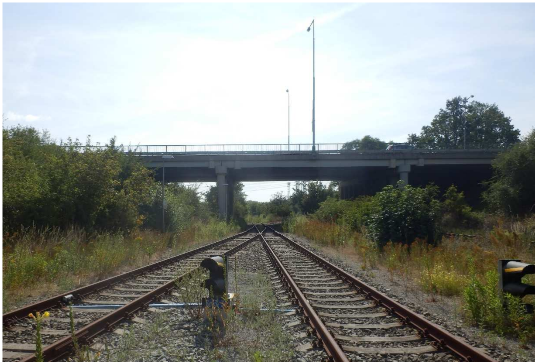
Obrázek 24: Traťový úsek Stará Paka – Mladá Boleslav město, km cca 19,3 pohled ve směru staničení z vlečkových kolejí, stávající třípólový dálniční most bude zdemolován a postaven nový čtyřpólový umožňující převedení až 8. kolejí a cyklostezky vlevo.
