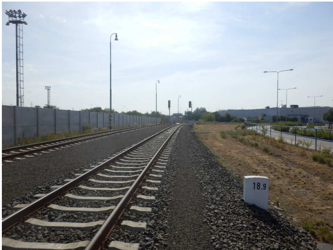
Obrázek 20: Traťový úsek Stará Paka – Mladá Boleslav město, km 18,9 pohled ve směru staničení, v ose stávajících kolejí jsou vedeny nové koleje č. 102 a 104, vpravo bude doplněna kolej č. 101, vlevo pak tři nové koleje (106, 108 a 14). Oplocení areálu Škoda auto bude demontováno a opětovně postaveno v nové poloze.
