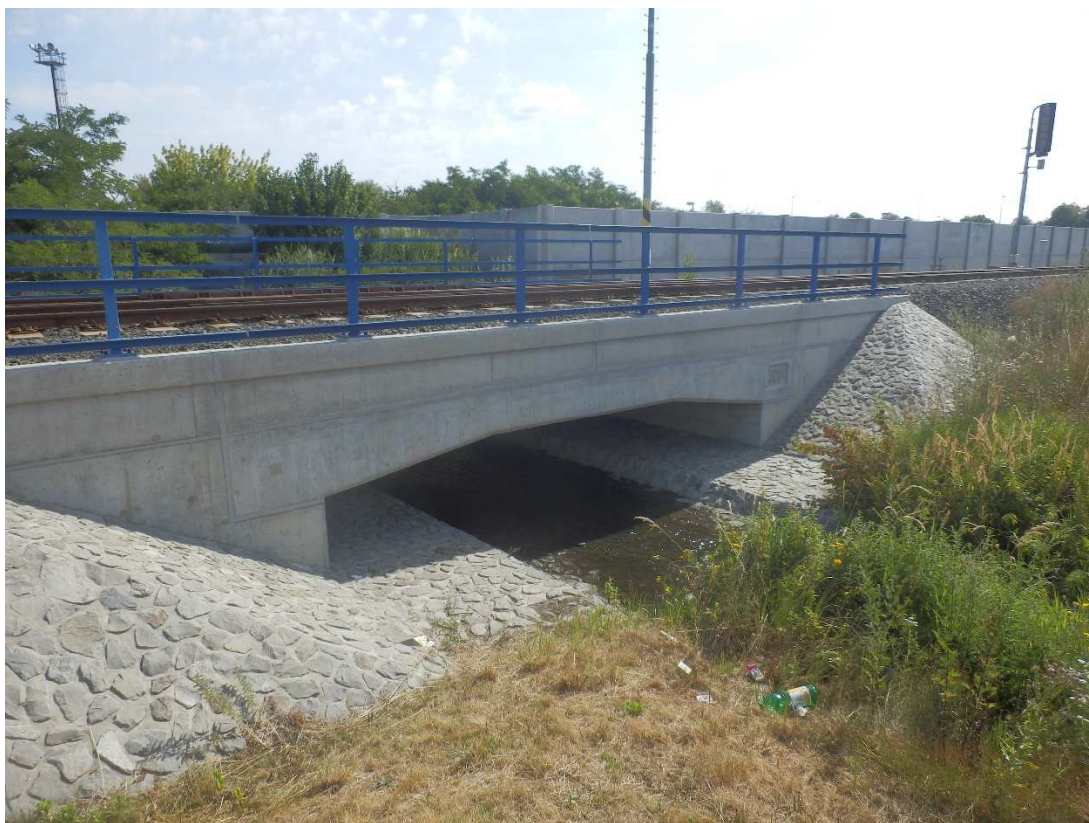
Obrázek 21: Traťový úsek Stará Paka – Mladá Boleslav město, most v ev km 19,009 pohled na výtok, v rámci stavby bude nutné most zbourat a postavit nový vícekolejný v odsunuté poloze cca 15m.
