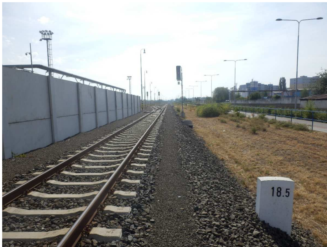
Obrázek 18: Traťový úsek Stará Paka – Mladá Boleslav město, km 18,5 pohled ve směru staničení, v ose stávající koleje je vedena nová kolej č.102, vpravo bude doplněna kolej č. 101, vlevo pak tři nové koleje. Oplocení areálu Škoda auto bude demontováno a opětovně postaveno v nové poloze.
