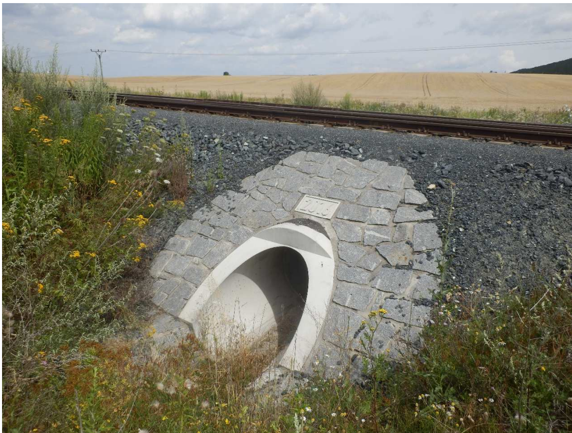
Obrázek 9: Traťový úsek Nymburk hl.n. – Mladá Boleslav hl.n., propustek v ev km 24,830, pohled na výtok, na nové dvukolejné trati bude zřízen před tímto v km 24,818 propustkem propustek nový.
